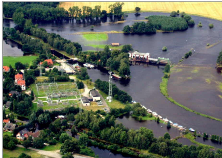
Wehranlage Oldau am 24.07.2002 – Blick stromab (Foto: WSA Verden, 2002)
